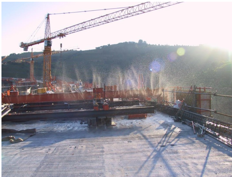
Figure 6.4 : exemple de cure à l'eau du tablier d'un pont (photo Eiffage).
